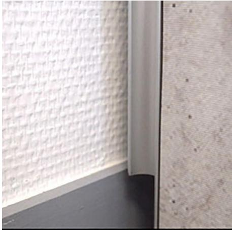
Les profils «POIGNEE», permettent de compenser les épaisseurs de plinthe. Nous fabriquerons le profil poignée en déduisant la hauteur de(s) plinthe(s).
